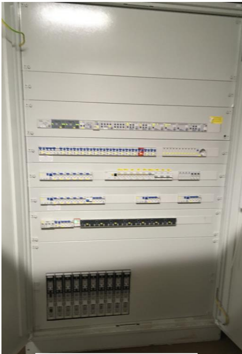
(Elektrohauptverteiler)
