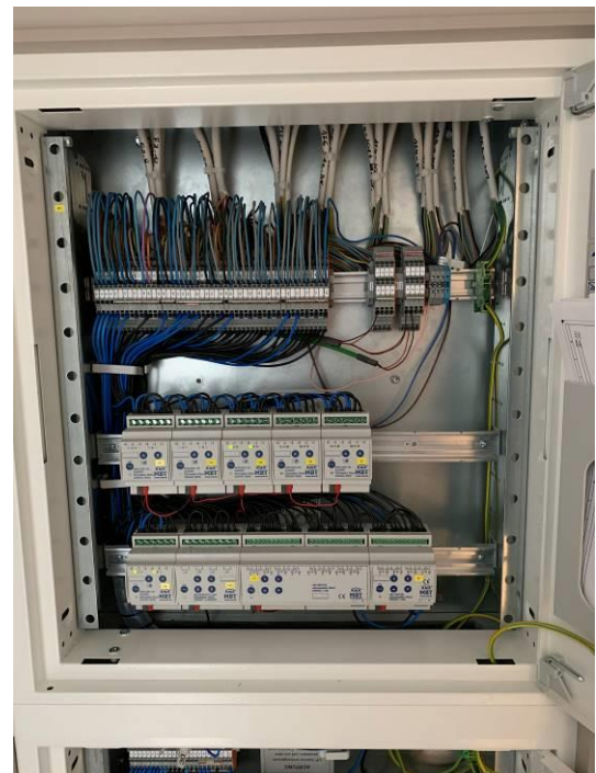
KNX-EIB-Verteiler
