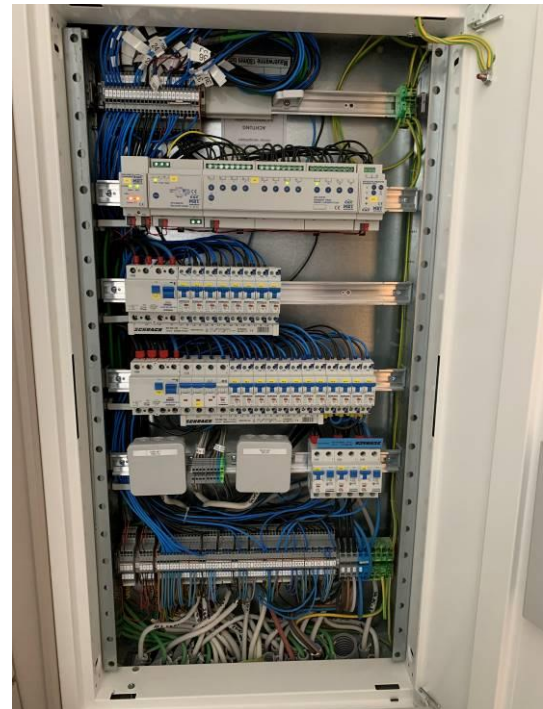
Elektroverteiler mit KNX-EIB-Aktorik
